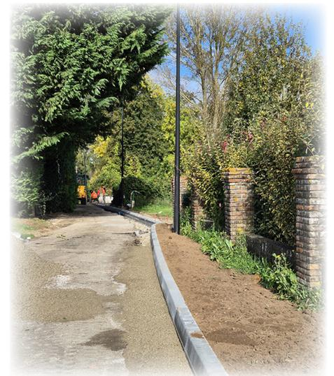
*Pour éviter l'afflux d'eau chemin des Pileux, des travaux se sont déroulés au mois d'octobre, afin de faciliter l'écoulement en cas de forte pluie.*
